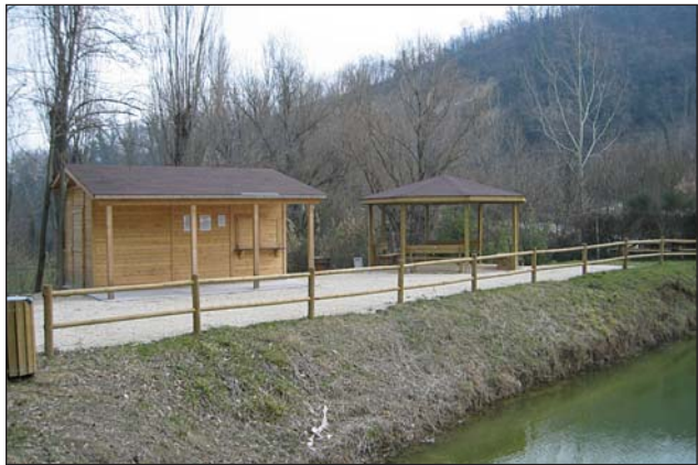
Laghetto di pesca sportiva di Saludecio. Strutture per pescatori con relativa messa in sicurezza delle sponde.
