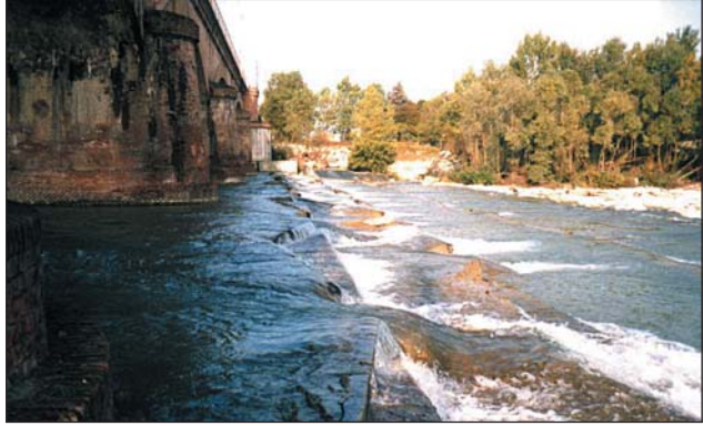
Scala di risalita Pontetaro.
