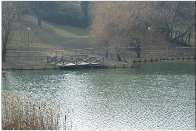
Laghetto di Cava nel parco Ausa V Peep. Piattaforma per pesca e messa in sicurezza delle sponde.
