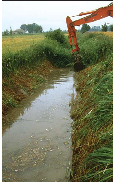
Fotografia 20 - Sfalcio meccanico annuale delle erbe acquatiche. Tali operazioni, effettuate spesso senza rigore scientifico, finiscono per compromettere la continuità e la sopravvivenza della comunità acquatica.
