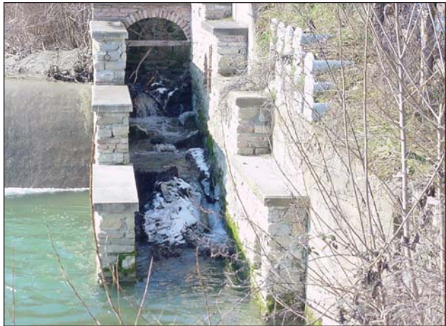
La scala di risalita realizzata sul torrente Senio in località Poggiolino (Riolo Terme).
