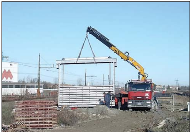
Fotografia 2 - La delicata fase del posizionamento in sito della paratoia (Fotografia a cura del Consorzio della bonifica Reno-Palata).
