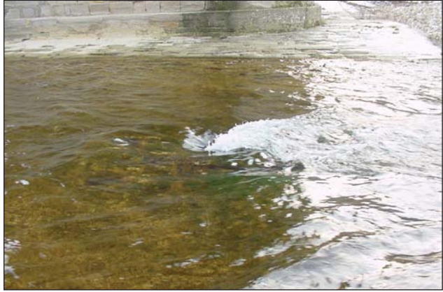
Particolare della botola di presa collocata al centro dell'alveo del fiume Lamone.
