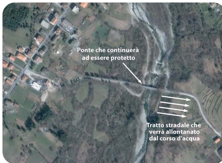
Fig. 3.5 Torrente Gottero, presso Sesta Godano: nella vista dall'alto è evidenziato il tratto stradale oggetto di arretramento (rispetto alla sponda); il ponte invece viene protetto con alcune opere idrauliche
