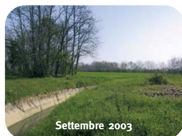
Fig. 3.15 Eliminazione del rivestimento in calcestruzzo e ampliamento della sezione in alcuni tratti della Fossa Pagana. Si osservi, nella sequenza in basso, che là dove non è stato possibile intervenire su entrambe le sponde si è proceduto con un ampliamento su una sola sponda; il ristagno di acque piuttosto ricche di nutrienti favorisce la naturale ricrescita della vegetazione emergente in tempi piuttosto rapidi. Fonte: Consorzio di bonifica Dese
