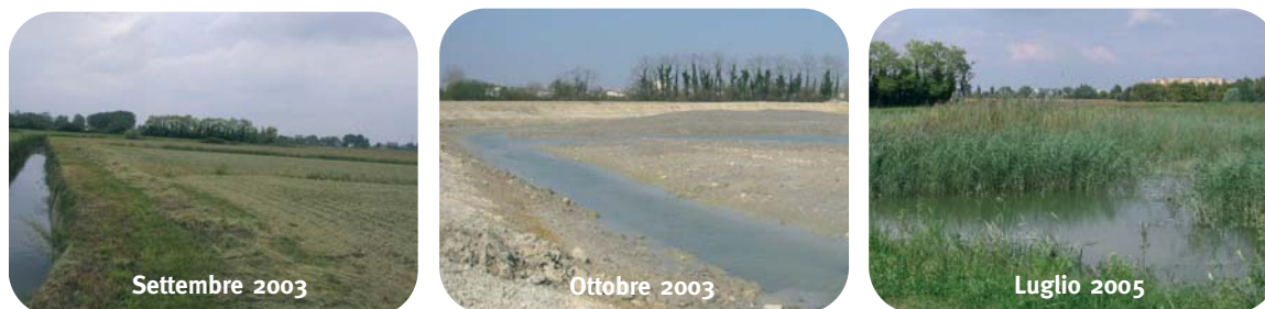
Fig. 3.16 Eliminazione del rivestimenti in calcestruzzo e creazione di una zona umida in alveo in un tratto della Fossa Pagana (foto: Consorzio di Bonifica Dese Sile). www.bonificadesesile.net
