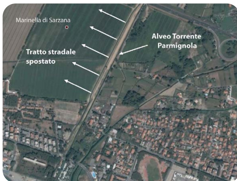
Fig. 3.4 Torrente Parmignola, presso Marinella di Sarzana: nella vista dall'alto è evidenziato il tratto stradale oggetto di arretramento (rispetto alla sponda); si nota anche l'alveo più ampio del T. Parmignola.
