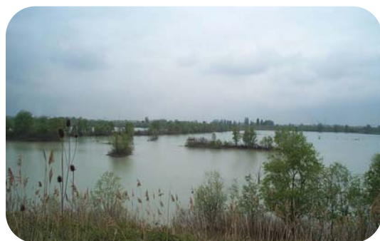
Fig. 2.4 La cassa di espansione del fiume Secchia è di tipologia mista: uno sbarramento a bocca tarata non regolabile provoca il rigurgito idraulico nella cassa in linea finché, superato un dato livello, le acque sfiorano nella cassa laterale. Sopra: manufatto regolatore con le quattro bocche tarate (le frecce indicano l'uscita dalle bocche). Sotto: la zona umida laterale, di elevato interesse naturalistico (Foto sopra: F. Romagnolli; sotto: R. Paita; da CIRF 2006, Mazzanti Editore).
