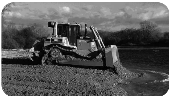
Fig. 3.8 Introduzione artificiale in alveo di sedimenti risultanti dal ripristino di bracci morti. (Foto: E. Favre, CREM)
