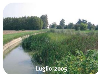
Fig. 3.15 Eliminazione del rivestimento in calcestruzzo e ampliamento della sezione in alcuni tratti della Fossa Pagana. Si osservi, nella sequenza in basso, che là dove non è stato possibile intervenire su entrambe le sponde si è proceduto con un ampliamento su una sola sponda; il ristagno di acque piuttosto ricche di nutrienti favorisce la naturale ricrescita della vegetazione emergente in tempi piuttosto rapidi. Fonte: Consorzio di bonifica Dese
