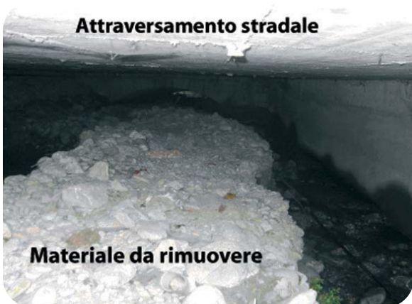
Fig. 3.18 Due classici interventi di rimozione di materiale in prossimità di strozzature; il materiale estratto viene poi reintrodotta nuovamente in alveo, in differenti punti.
