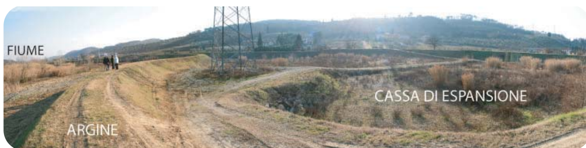
Fig. 2.1 Le casse di espansione solo in certi casi sono grandi aree con valore anche naturalistico e fruitivo; molto spesso sono aree altamente artificiali, racchiuse fra argini che le separano dal fiume e dal territorio; ecco un esempio fornito dall’immagine panoramica della cassa di espansione di Montelupo sul Torrente Pesa in Toscana (foto B. Boz).
