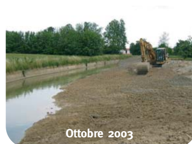
Fig. 3.15 Eliminazione del rivestimento in calcestruzzo e ampliamento della sezione in alcuni tratti della Fossa Pagana. Si osservi, nella sequenza in basso, che là dove non è stato possibile intervenire su entrambe le sponde si è proceduto con un ampliamento su una sola sponda; il ristagno di acque piuttosto ricche di nutrienti favorisce la naturale ricrescita della vegetazione emergente in tempi piuttosto rapidi. Fonte: Consorzio di bonifica Dese
