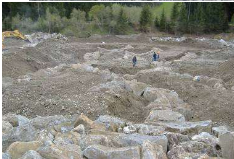
Figura 40 - L'intervento di recupero della larghezza dell'alveo del Rio Mareta descritto nella figura precedente ha previsto il ripristino della continuità longitudinale dell'alveo grazie alla demolizione di 16 briglie (immagine in alto), con evidenti benefici sia per l'ecosistema e la fauna ittica che per l'evoluzione morfologica del torrente stesso, che è ritornato così ad essere un sistema dinamico. Per prevenire l'innescarsi di nuove incisioni e per garantire l'innalzamento del livello dell'alveo, il progetto ha previsto il consolidamento del fondo mediante rampe (immagine in basso a sinistra) costituite da massi ciclopici con un peso minimo di 2 t (immagine in basso a destra). La peculiarità di queste rampe è quella di essere state per la maggior parte ricoperte con materiale sciolto ed armonizzate così con il paesaggio circostante, ricreando un alveo con caratteristiche morfologiche naturali, come visibile in Figura 39 (anno 2010), ma che contestualmente presenti, in profondità, elementi che garantiscano la protezione contro ulteriori incisioni ed effetti di canalizzazione, che potrebbero di nuovo creare problemi idraulici a valle, a Vipiteno. Intervento e foto: Provincia Autonoma di Bolzano - Ripartizione Opere Idrauliche.
