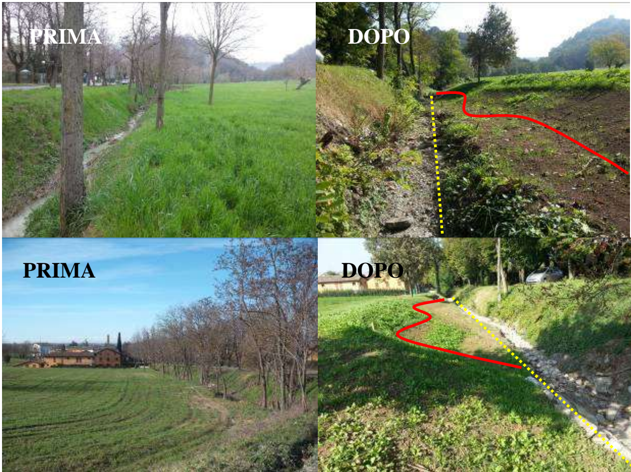
Figura 11 - Esempio di creazione di piana inondabile in un corso d'acqua non arginato mediante abbassamento del piano campagna (rio Bianello, Comune di Quattro Castella in Provincia di Reggio Emilia). Anche questo intervento, mostrato nelle immagini subito dopo la realizzazione dei lavori, fa parte delle azioni sviluppate nell'ambito del Progetto Europeo LIFE+ RII, come quello descritto in Figura 10. (linea gialla: sponda originale; linea rossa: sponda arretrata mediante sbancamento dell'area perifluviale). Intervento realizzato dal Consorzio di Bonifica dell'Emilia Centrale (RE). Foto: Marco Monaci.
