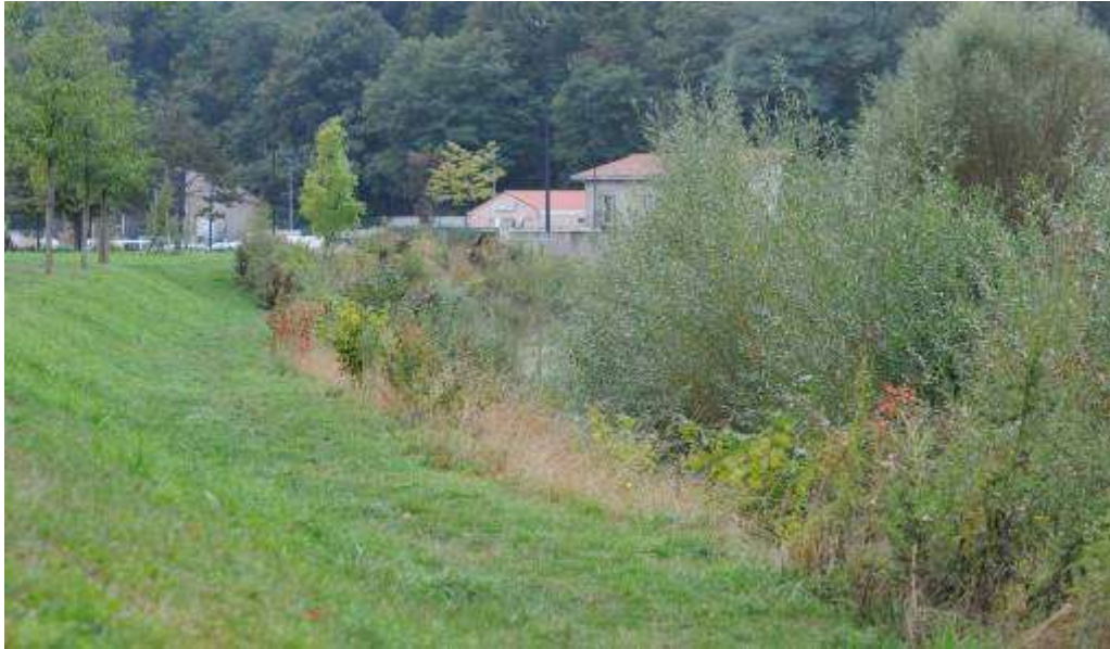
Figura 47 – Esempio di riapertura e riqualificazione di un tratto del fiume Ondaine, affluente della Loira, nelle vicinanze della città di Saint Etienne (Francia).
