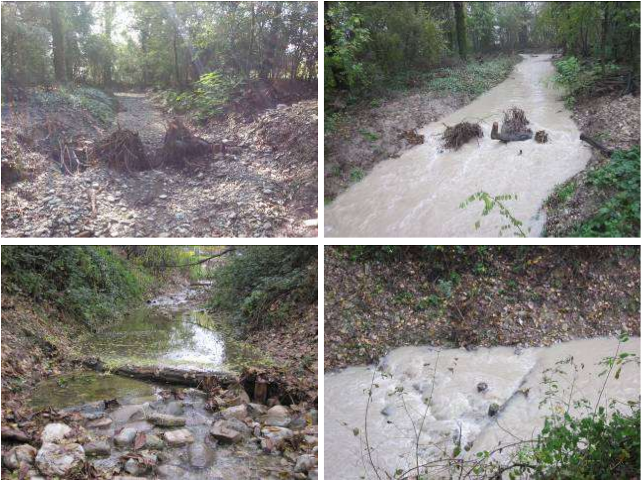
Figura 19 – Esempio di posizionamento in alveo di strutture in legno per l’aumento della scabrezza e la diversificazione degli habitat (rio Lavezza, Comune di Albinea in Provincia di Reggio Emilia). L’intervento è stato realizzato nell’ambito del Progetto Europeo LIFE+ RII ( http://ambiente.regione.emilia-romagna.it/life-rii/temi/progetto-life-rii/life-rii ) di cui la Regione Emilia-Romagna è ente capofila. Nelle prime due foto in alto è mostrato a sinistra l’ancoraggio alla sponda di due tronchi dotati di radice esposta e a destra l’intervento attraversato da una morbida del rio. Nelle due foto in basso è mostrato a sinistra un tronco posto trasversalmente all’alveo ancorato alle sponde e a destra l’intervento attraversato da una morbida del rio Lavezza. Intervento realizzato dal Consorzio di Bonifica dell’Emilia Centrale (RE). Foto: Marco Monaci, Aronne Ruffini.
