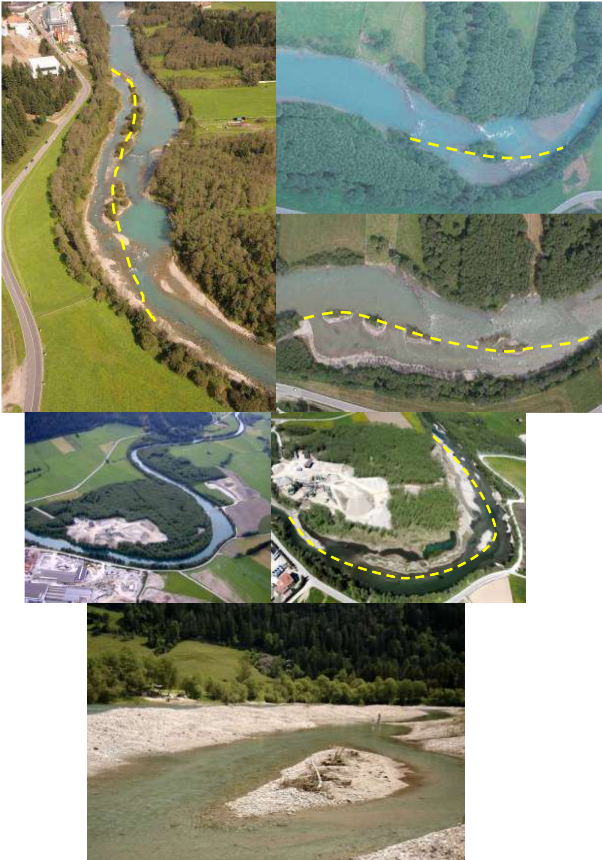
Figura 22 – Esempio di rimozione di difese spondali e allargamento di sezione. Immagini in alto: intervento realizzato lungo il torrente Aurino a Campo Tures (Provincia Autonoma di Bolzano).
