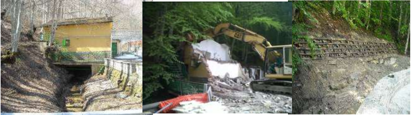
Figura 48 – L'intervento qui rappresentato è stato realizzato nei pressi della sorgente del fiume Tevere in località Ocri nel comune di Verghereto (Provincia di Forlì Cesena).
