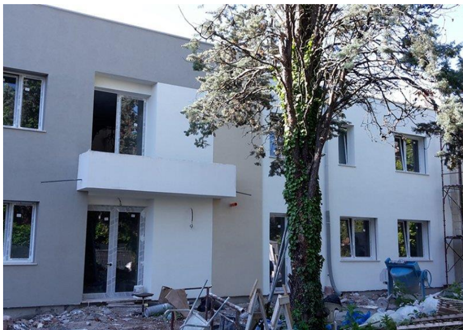
Figura 3 Fotografia dell’avvenuta riqualificazione di Casa Fabbri
