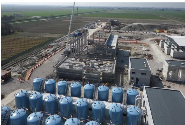
Figura 9 Fotografia aerea del potabilizzatore della Standiana
