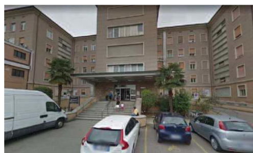
Figura 8 Fotografia del PO di Ravenna
