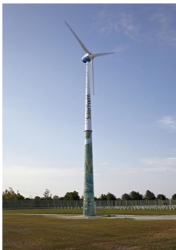
Figura 7 Fotografia dell'impianto realizzato in relazione all'Azione 4.8A
