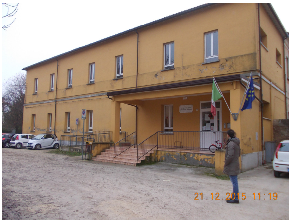
Foto 4 – Facciata di ingresso edificio scolastico
