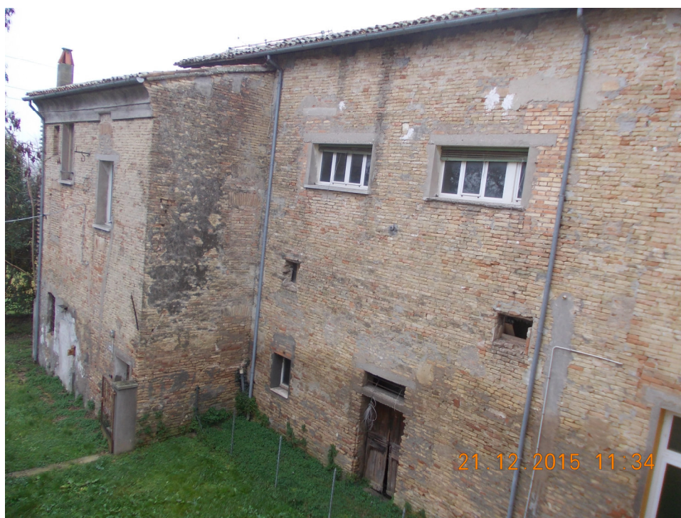
Foto 5 – Lato interno ala ovest
