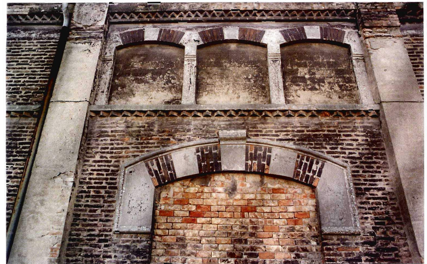
PARTICOLARE DEI MOTIVI DECORATIVI IN LATERIZIO DELLA FACCIATA
