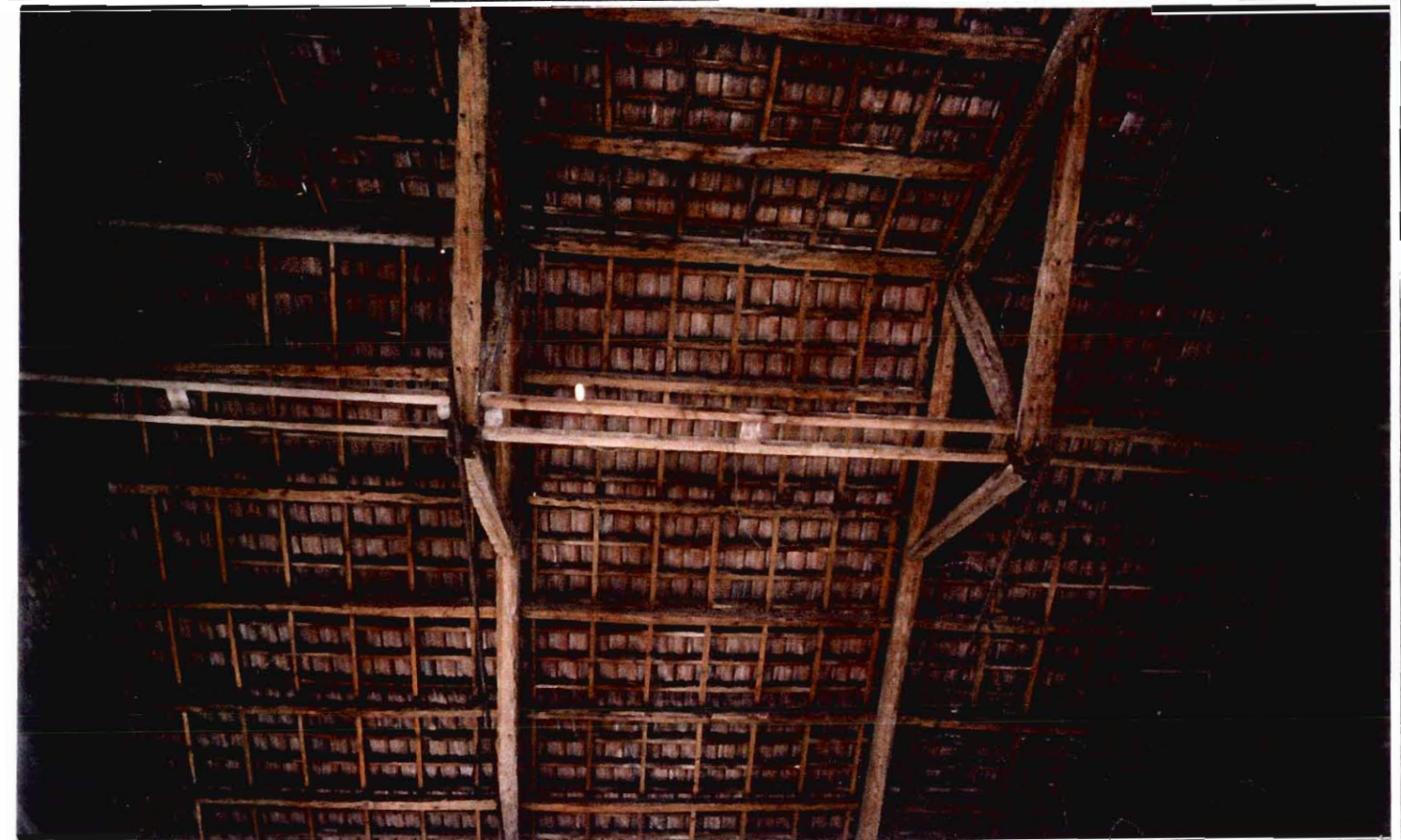
PARTICOLARE DELLA COPERTURA CON CAPRIATE IN LEGNO
