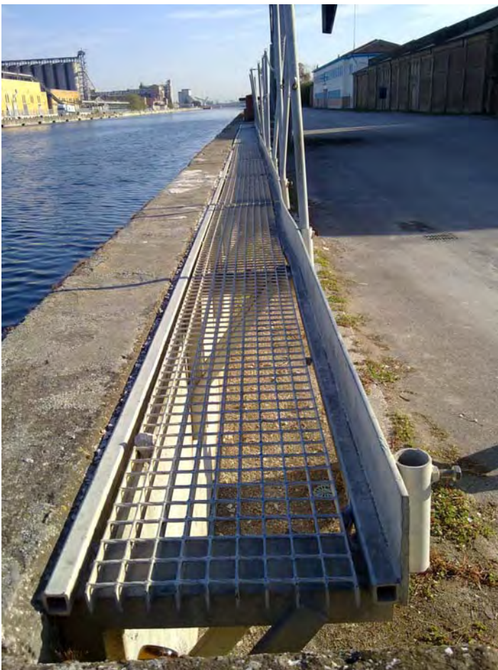
Via D'Alaggio – Particolare della passerella
