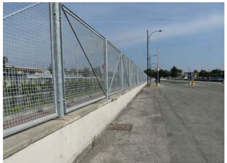
Via Darsena - Particolare della recinzione demaniale
