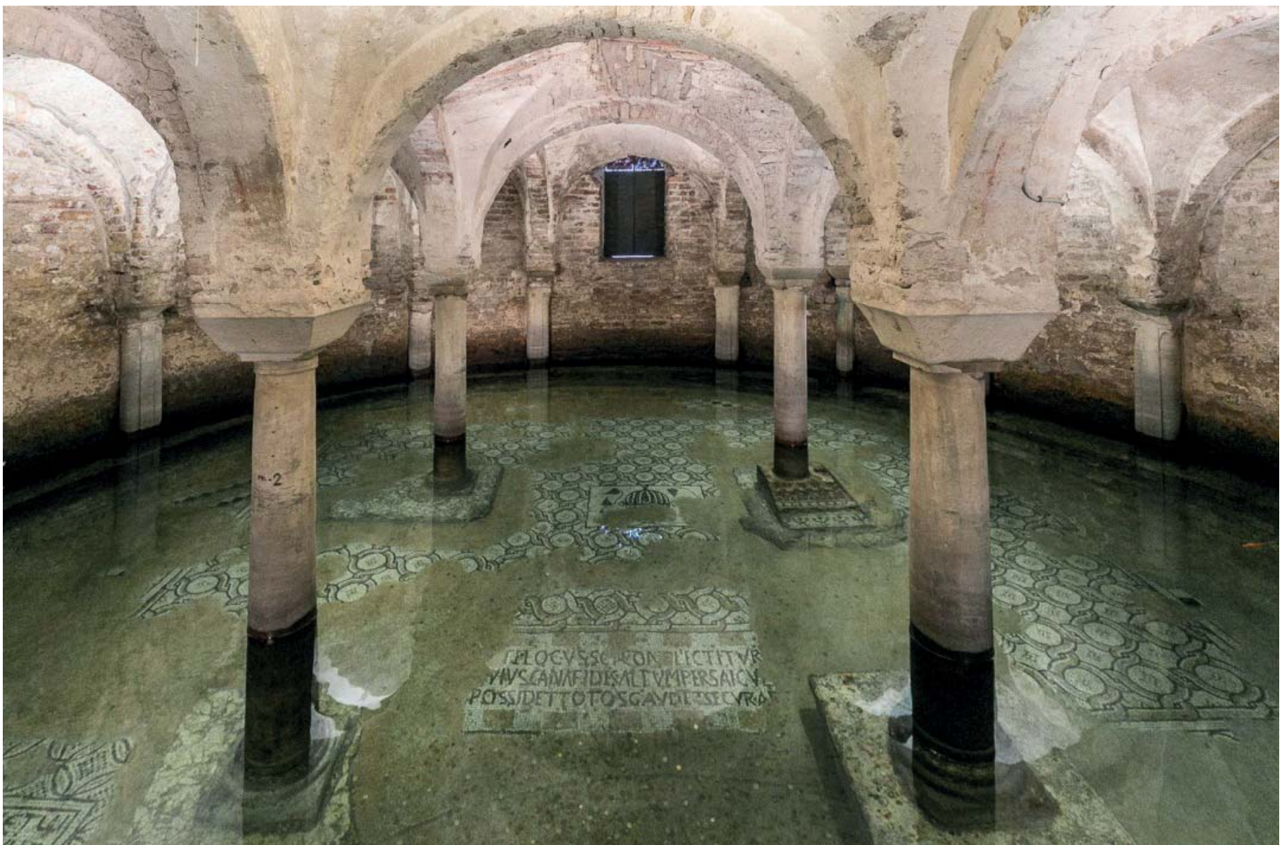
La cripta della chiesa di San Francesco allagata per il fenomeno della subsidenza
