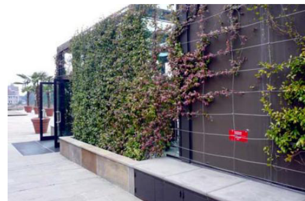
Matteo Thun, Terme di Merano (BZ), 2005: scala di accesso al parcheggio interrato. La vegetazione è supportata da un reticolo di cavi metallici tesi a qualche cm. dalla superficie della chiusura retrostante. Come si può notare nella parte destra della foto, l'ancora non completo sviluppo della pianta lascia intravedere il sistema di supporto
