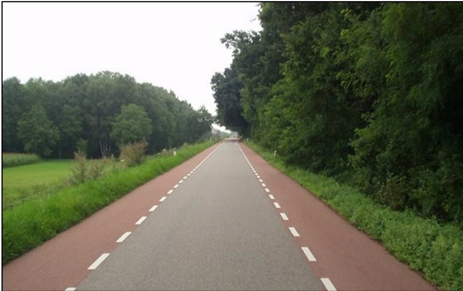
Esempio di strada extraurbana a prevalente uso ciclabile (i pittogrammi possono sostituire la colorazione)
