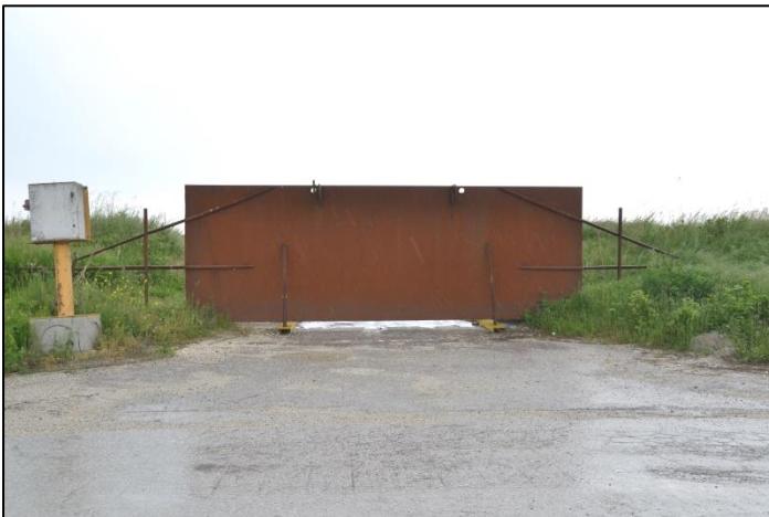
FIGURA 13 – ACCESSO DA VIA FOSSO GHIAIA COMPLETAMENTE PRECLUSO.
