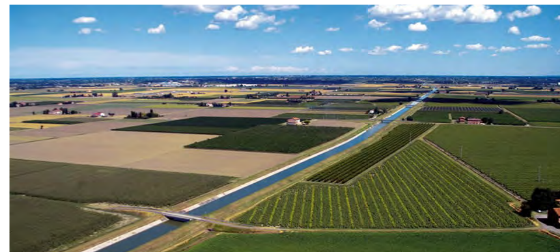
Il passaggio del CER - Canale Emiliano Romagnolo in un tratto di campagna ↑
