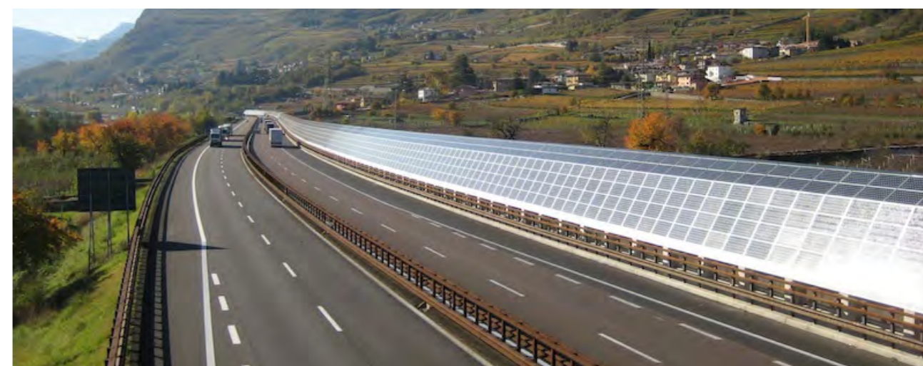
Impianto fotovoltaico sull'autostrada del Brennero ↑
