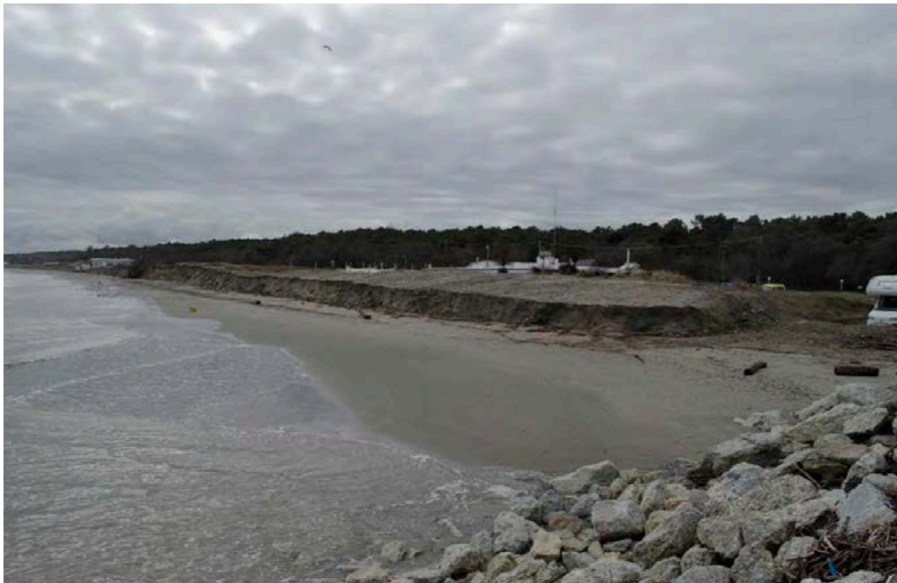
↑ Tracce di erosione costiera sul litorale, Marina Romea
