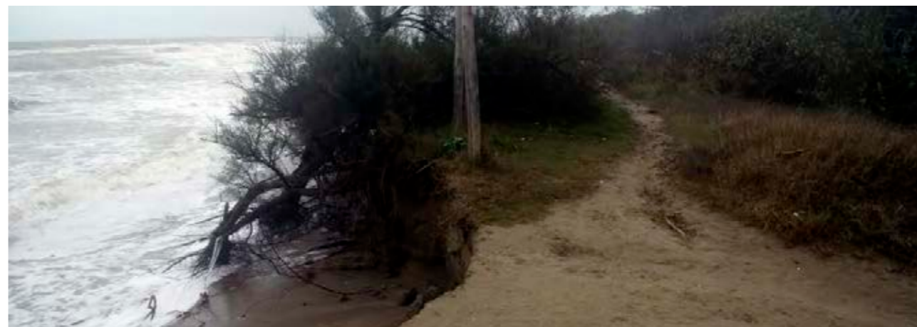
Erosione costiera nelle dune in area di riserva ↑
