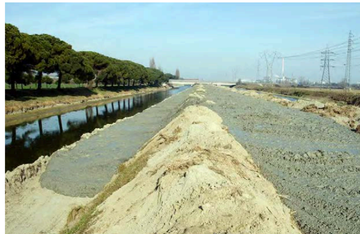
Lavori sul Canale Magni, marzo 2019 ↑
