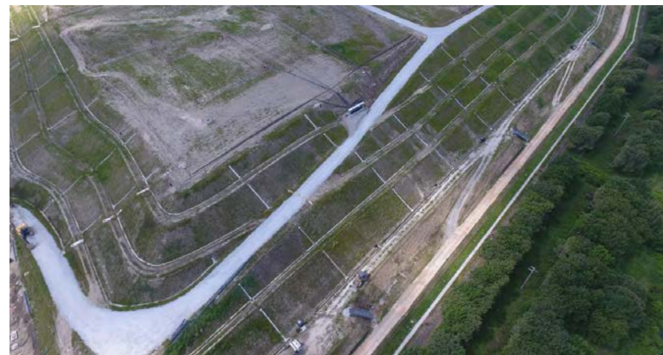
Realizzazione della copertura della discarica di rifiuti non pericolosi ↑
