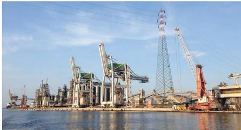
Autorità di Sistema Portuale - consistono nell'escavo di 5 milioni di metri cubi di sedimenti, per approfondire i fondali del porto sino a -12,5 mt, nel rifacimento del primo lotto di banchine esistenti (per oltre 6,5 km) per adeguarle ai nuovi fondali e nella realizzazione di una nuova banchina della lunghezza di oltre 1.000 mt in Penisola Trattaroli a servizio di una nuova area portuale da destinarsi principalmente a Terminal Container.
