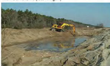
Scavi per la formazione dello stagno
