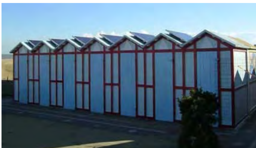
Esempio: inserimento pannelli in copertura esistente.
