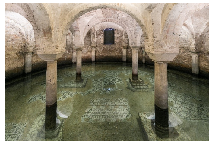
La cripta della chiesa di San Francesco allagata per il fenomeno della subsidenza
