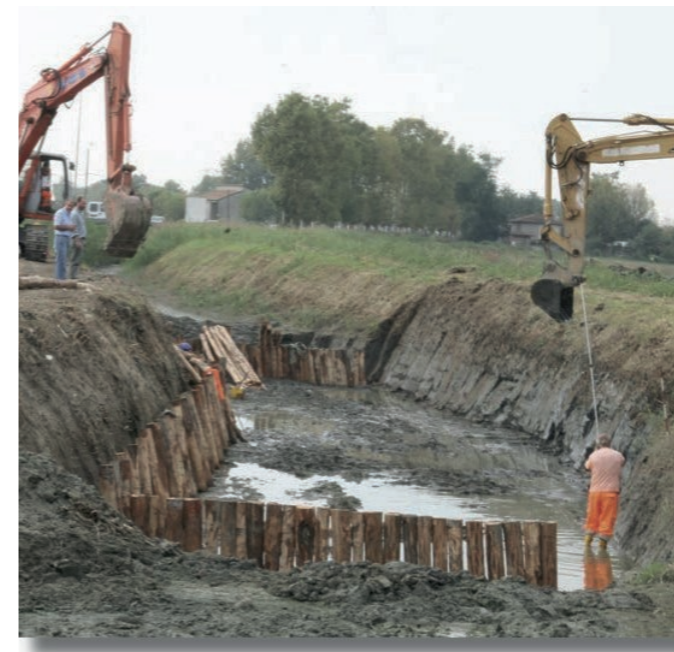
Trappola per sedimenti: Canale di San Giovanni (Consorzio di bonifica pianura di Ferrara, 2008 - Comune di San Giovanni in Persiceto- Provincia di Bologna)
