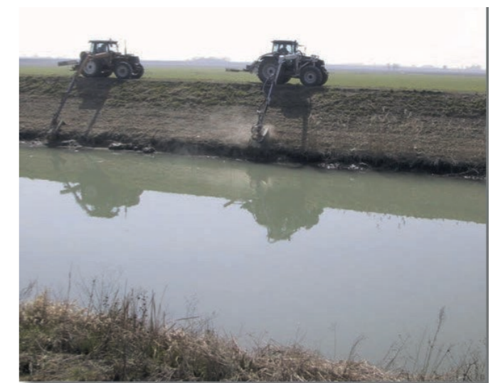
Nel corso delle tradizionali operazioni di sfalciamento completo della vegetazione, il passaggio delle attrezzature di taglio sulla scarpata spondale provoca inevitabilmente danni al piede di sponda, che richiedono successivi interventi di sistemazione e riprofilatura. (Foto: Consorzio di bonifica Acque Risorgive)
