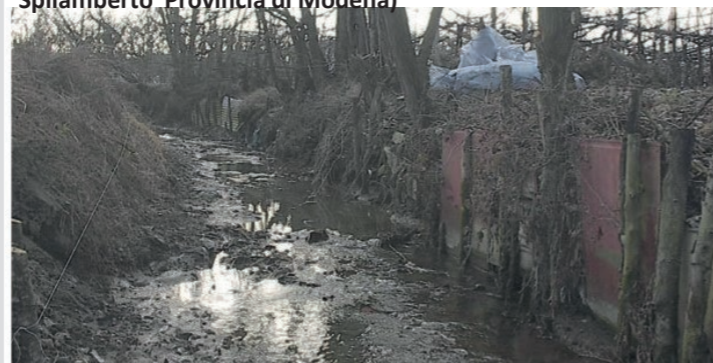
Palizzata rinverdita: Canale di San Pietro (Consorzio della bonifica Burana, 2004-05 - Comune Spilamberto Provincia di Modena)
