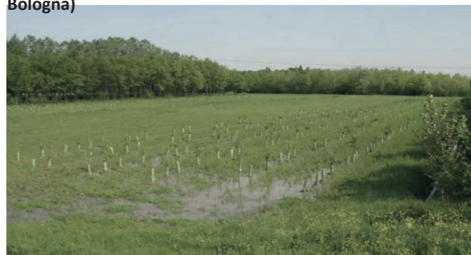
Cassa di espansione del Dosolo (Consorzio della bonifica Renana - Comune di Sala Bolognese - Provincia di Bologna)
