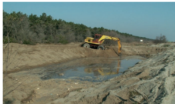
Scavi per la formazione dello stagno
