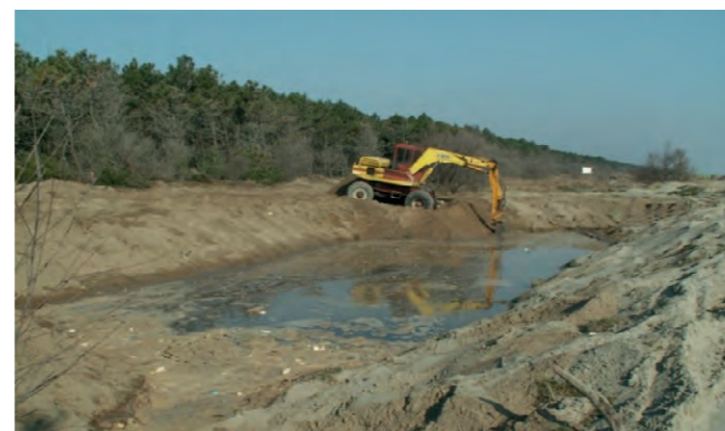
Scavi per la formazione dello stagno
