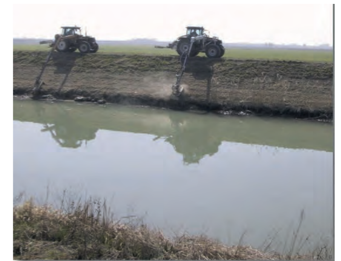
Nel corso delle tradizionali operazioni di sfalcio completo della vegetazione, il passaggio delle attrezzature di taglio sulla scarpata spondale provoca inevitabilmente danni al piede di sponda, che richiedono successivi interventi di sistemazione e riprofilatura. (Foto: Consorzio di bonifica Acque Risorgive)
