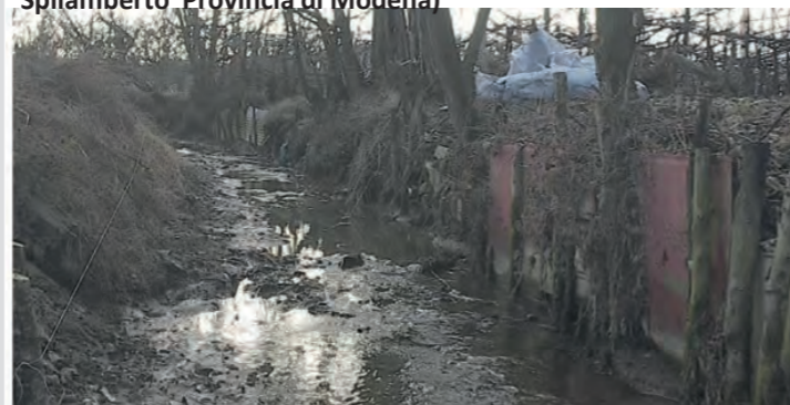
Palizzata rinverdita: Canale di San Pietro (Consorzio della bonifica Burana, 2004-05 - Comune Spilamberto Provincia di Modena)
