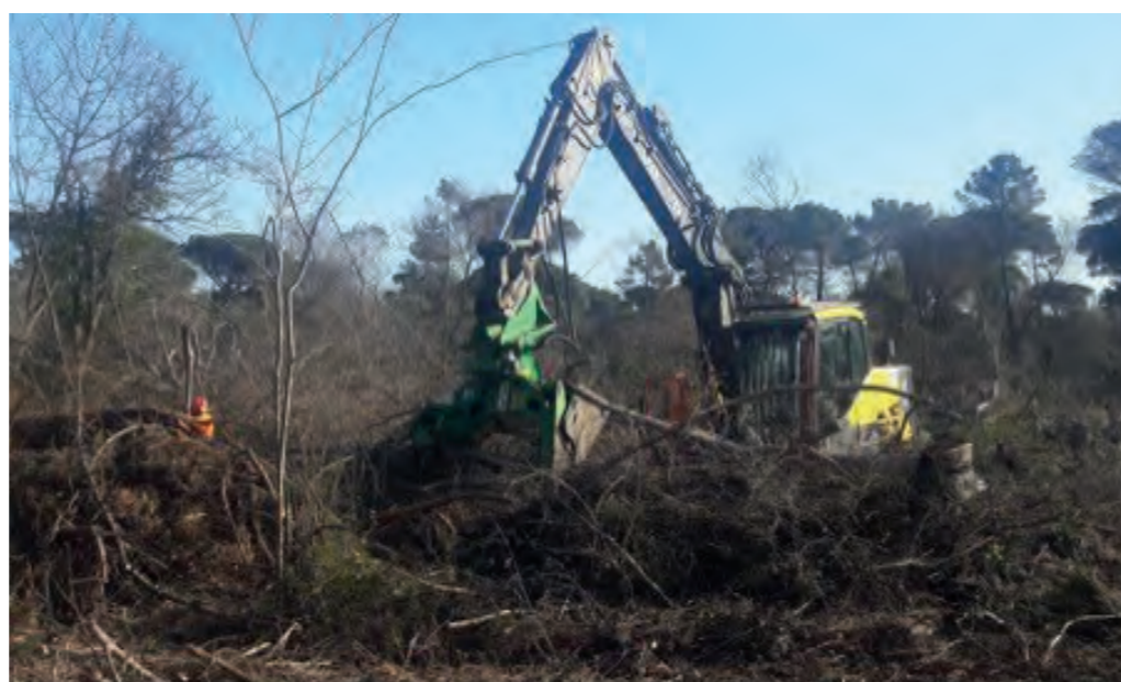
Interventi di rimozione del materiale legnoso abbattuto
