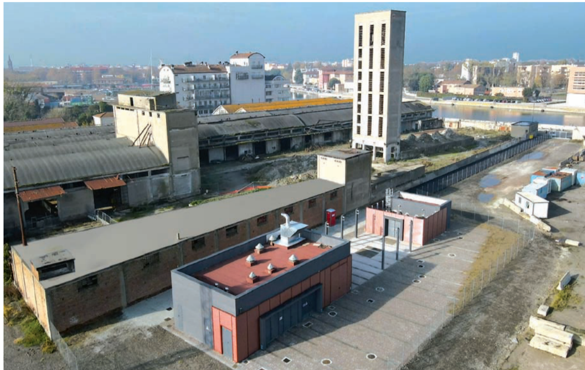
Vista dall'alto degli impianti del nuovo sistema fognario e di sollevamento acque
